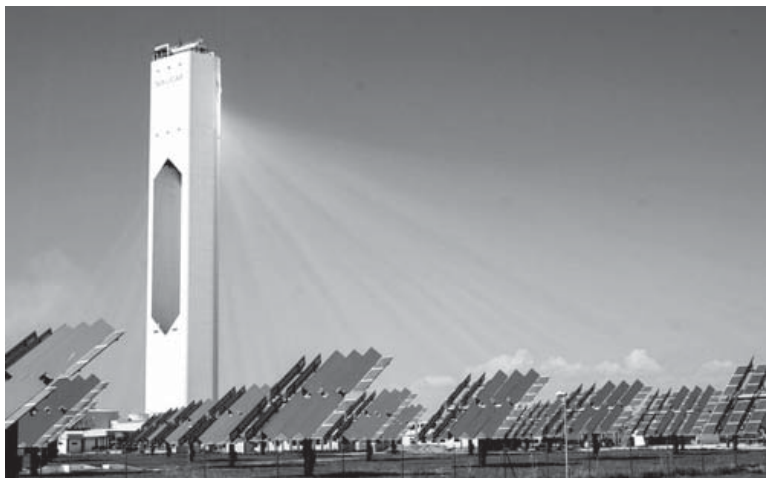
चित्र-9: स्पेन के एक पावर प्लांट का चित्र जो विद्युत उत्पादन करने वाले जनरेटरों को चलाने वाली भाप बनाने के लिए कोयले की बजाय सूर्य की ऊर्जा का उपयोग करता है। हवा में मौजूद धूल के कारण, हम वास्तव में सूर्य की किरणों के पथ को देख सकते हैं।
